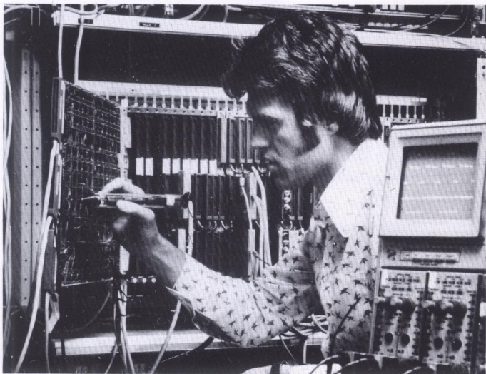
Inmätning av centralprocessor för AXE-system.
